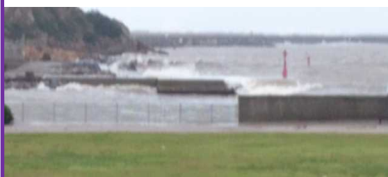
【第8防波堤(西浜地区入口)の越波状況】
